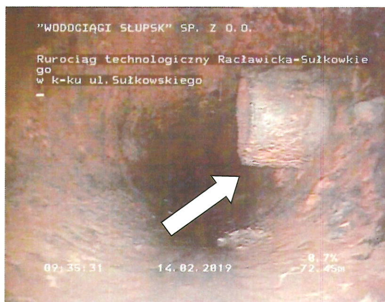
Rysunek 2 Inspekcja TV magistrali DN500 przeprowadzona w dniu 14.02.2019 roku. Na zdjęciu widoczne stare przyłącze do magistrali DN500. W miejscu przyłączy należy wykonać wykop i usunąć przeszkodę.
