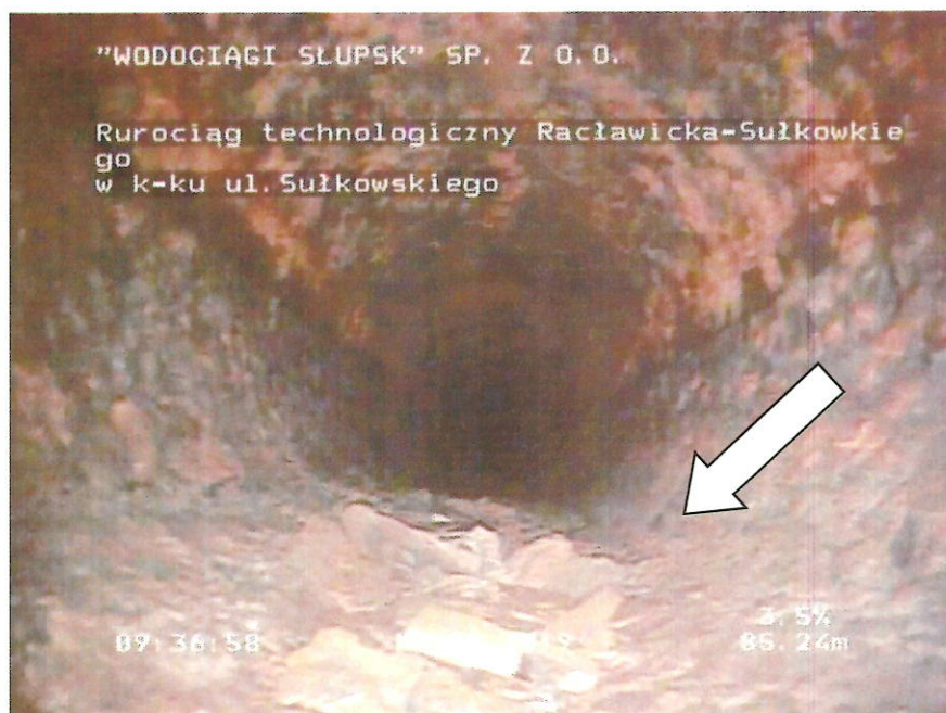
Rysunek 1 Inspekcja TV magistrali DN500 przeprowadzona w dniu 14.02.2019 roku. Na zdjęciu widoczne zalegające na dnie twarde osady żelaza i manganu
