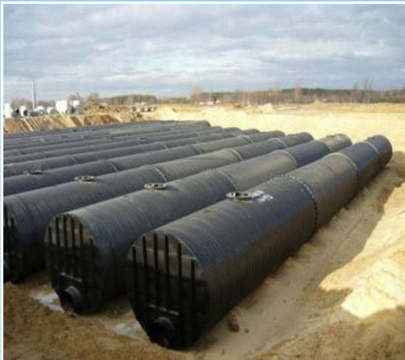
Zbiornik retencyjny rurowy stalowy Viacon
